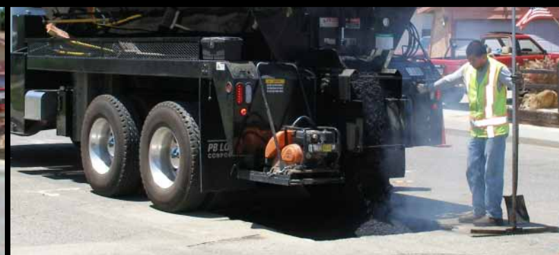
Add asphalt mix.
